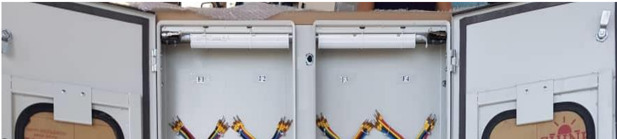
شکل شماره (پ ۴-۷) محل خروج سیم مودم در ستون بین دو بخش کنتور
