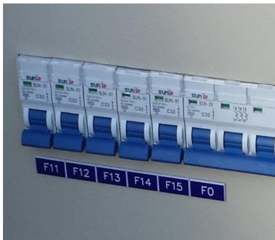
شکل(پ ۱): روش برچسب گذاری کلید مینیاتوری افقی
