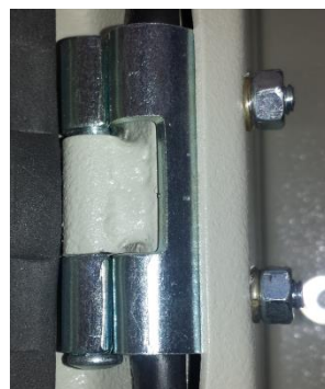
شکل (۸) - لولای مورد استفاده در تابلو
