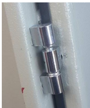
شکل (۸) - لولای مورد استفاده در تابلو
