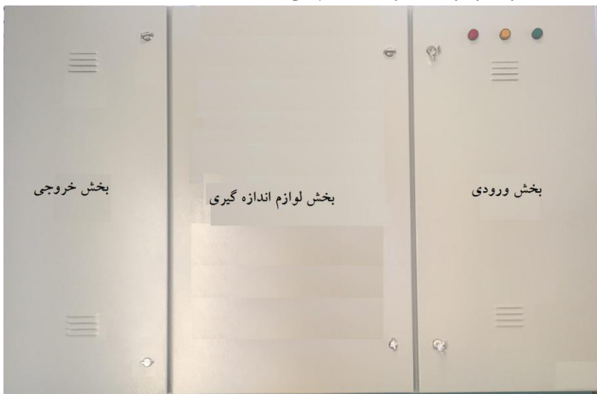
شکل (۱): نمای ظاهری تابلوی لوازم اندازه گیری چندکنتوری مستقیم
