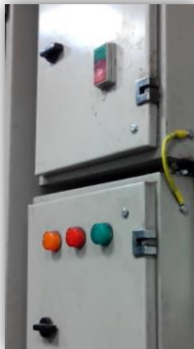
شکل ۹: نحوه اجرای همبندی اضافی دو تابلو برق مجاور
